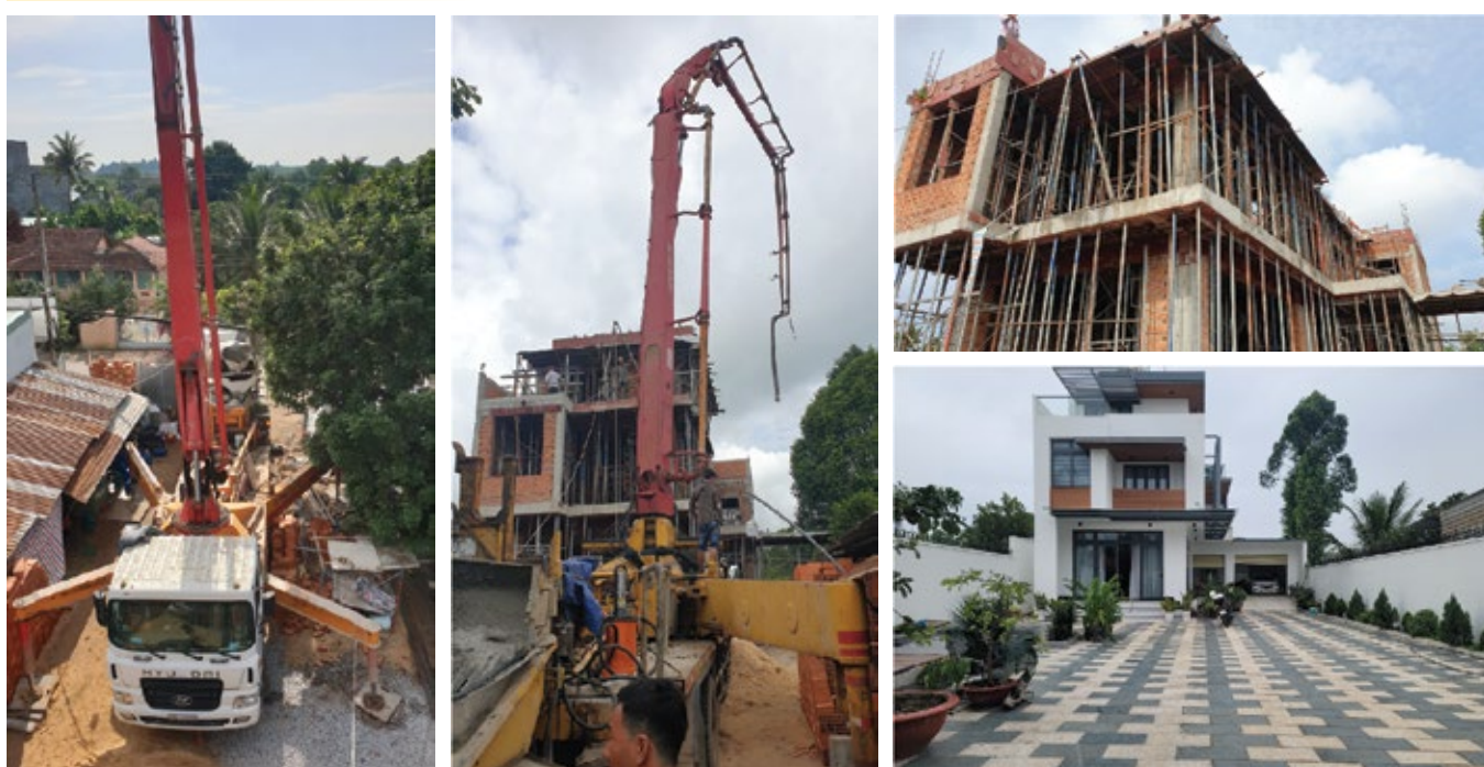
Thi công chìa khóa trao tay Villa Thái Bảo
